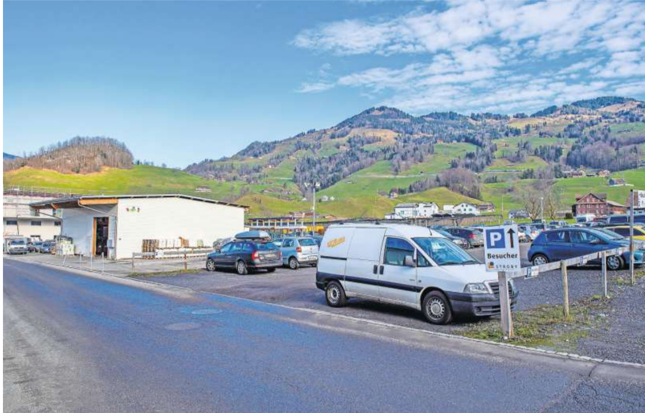
Hier im Steinbislin entsteht das neue Landi-Gebäude.
